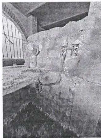
APLANADOS EN MUROS CON MOTERO CEMENTO- ARENA DE RÍO DE LOCALES COMERCIALES.
