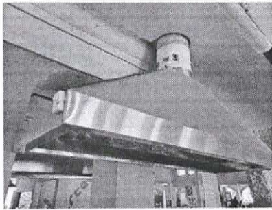
SUMINISTRO Y COLOCACIÓN DE EXTRACTORES DE AIRE PARA CAMPANA.
