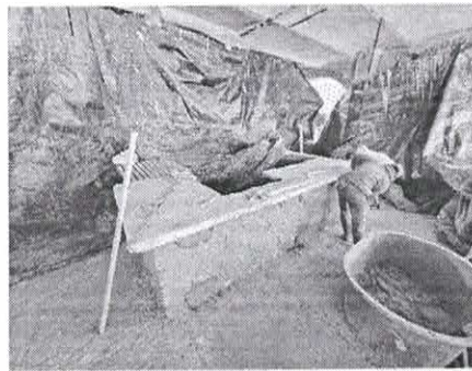
DEMOLICIÓN Y RETIRO DE PEGAPISO EN BARRAS EXISTENTES DE FORMA MANUAL Y/O MECÁNICA.
