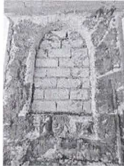
CONSTRUCCIÓN DE MURO DE LADRILLO DE LAMA EN LOCALES DE COMIDA.
