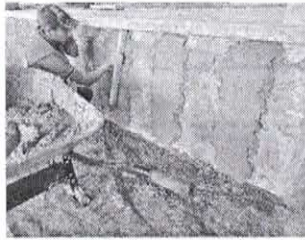
CONSTRUCCIÓN DE MURO DE LADRILLO DE LAMA EN LOCALES DE COMIDA.
