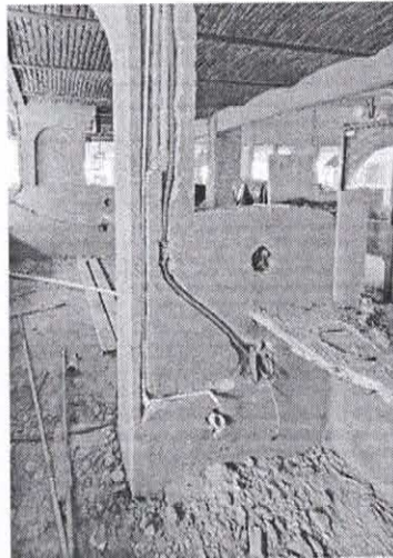
SUMINISTRO Y COLOCACIÓN DE MATERIALES PARA LA SALIDA HIDRÁULICA DE TARJA.
