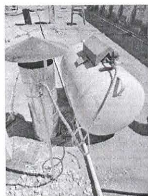
SUMINISTRO Y COLOCACIÓN DE LINEA PRINCIPAL DE AGUA POTABLE A BASE DE CPVC DE 1" PARA SUMINISTRO.
