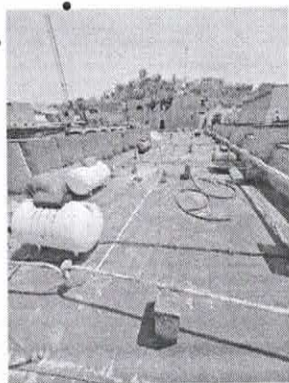
SUMINISTRO Y COLOCACIÓN DE LINEA PRINCIPAL DE AGUA POTABLE A BASE DE CPVC DE 1" PARA SUMINISTRO.
