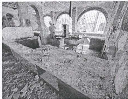
DEMOLICIÓN Y RETIRO DE PEGAPISO EN BARRAS EXISTENTES DE FORMA MANUAL Y/O MECÁNICA.
