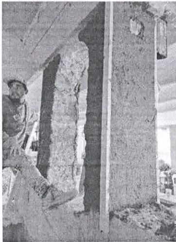
BOQUILLAS DE 15 A 30 CMS DE ANCHO CON MORTERO CEMENTO TERMINADO APALILLADO.
