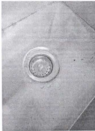
SUMINISTRO Y COLOCACIÓN DE MEZCLADORAS Y CONTRACANASTAS EN TARIJAS EXISTENTES.
