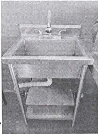
SUMINISTRO Y COLOCACIÓN DE MEZCLADORAS Y CONTRACANASTAS EN TARIJAS EXISTENTES.
