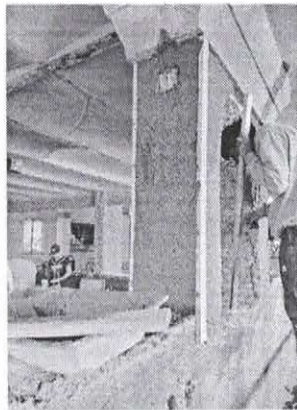
APLANADOS EN MUROS CON MOTERO CEMENTO- ARENA DE RÍO DE LOCALES COMERCIALES.
